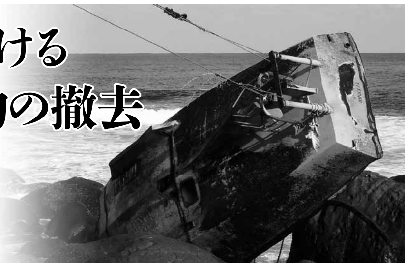
多滑車を使用した巻起し
