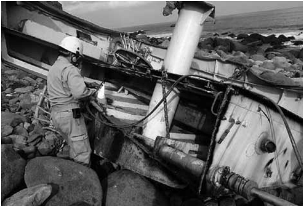
切断解体作業
